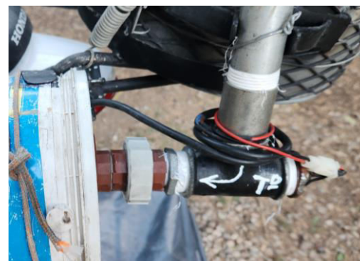
Bulbo de temperatura en la “T” de metal.
